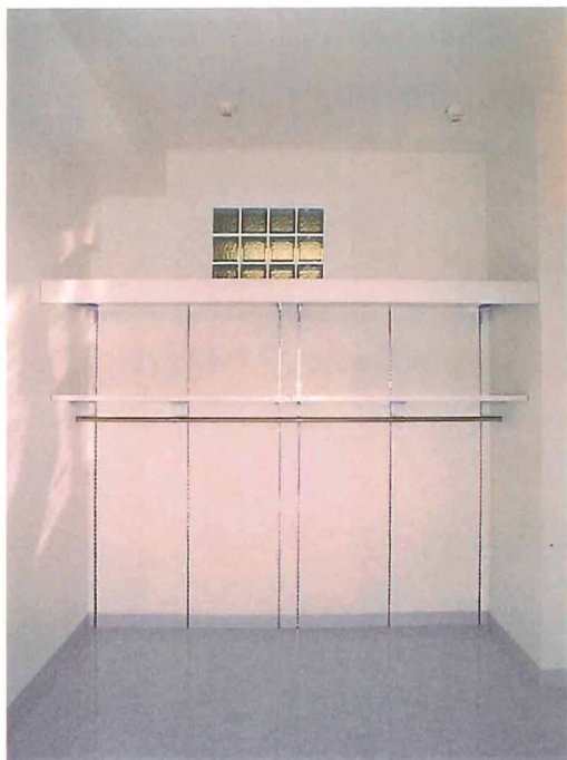
写真3 / 壁に埋め込んだチャンネル型サポート。ハンガーパイプや棚板が自由に増やせる
