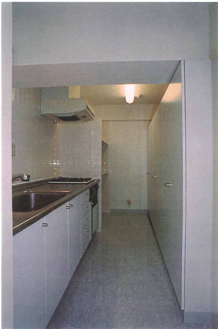
▲写真1 / リフォーム後。既存のキッチンを使用。扉は清潔感のある白に張り替え、全体を統一。バックの食器棚は扉とそろえた。奥には電化製品とゴミ箱のスペースを確保
